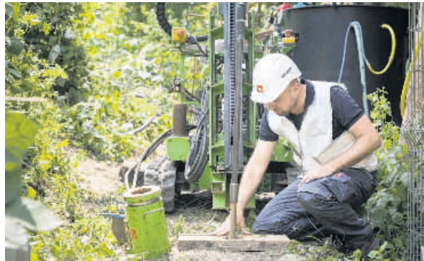
Über Bohrungen werden die Partikel in das Grundwasser injiziert. Dort verteilen sie sich selbst – dank einer speziellen Oberflächenmodifikation. Foto: Intrapore
